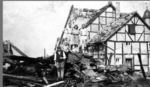
Beseitigung von Kriegsschäden an den Häusern in den Straßen Opferhof, Ecke Hinter der Kirche (02.08.1943). @Doris Werner
